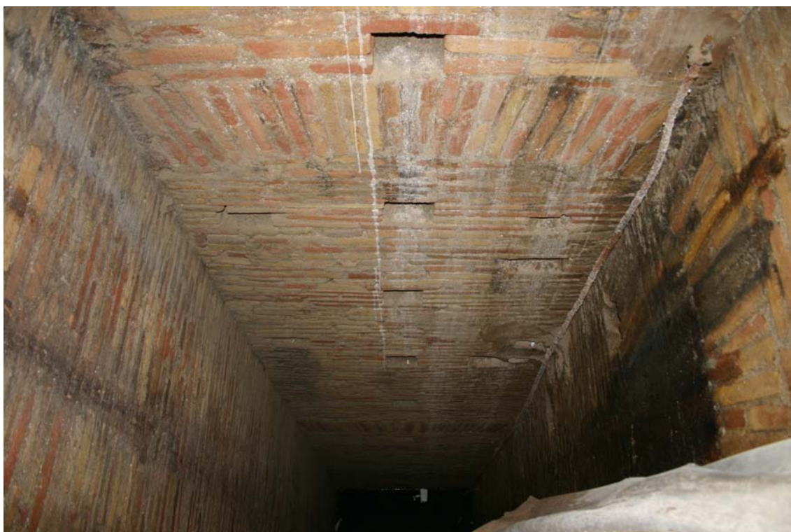
Vista del parament intern del pou U.E. 1001, fet de maons. S'observen els arcs de descarrega, així com els encaixos per facilitar l'accés a la part inferior.
