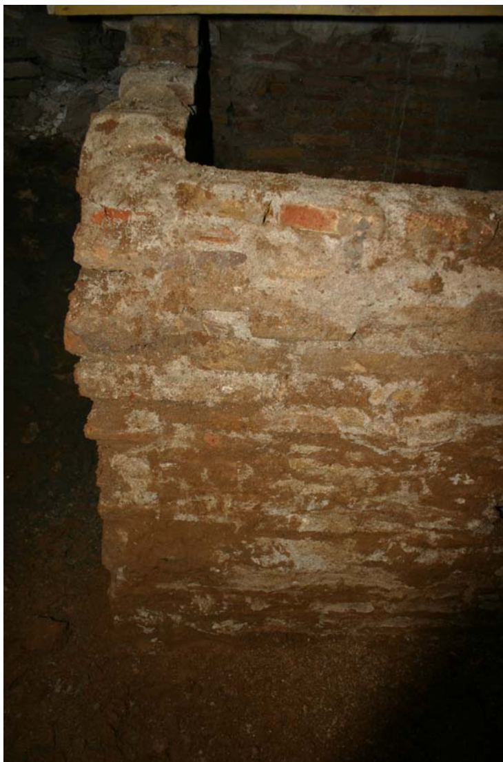
Detall del parament exterior del pou U.E: 1001, un cop excavat l'estrat d'argila on es retallava el mateix.
