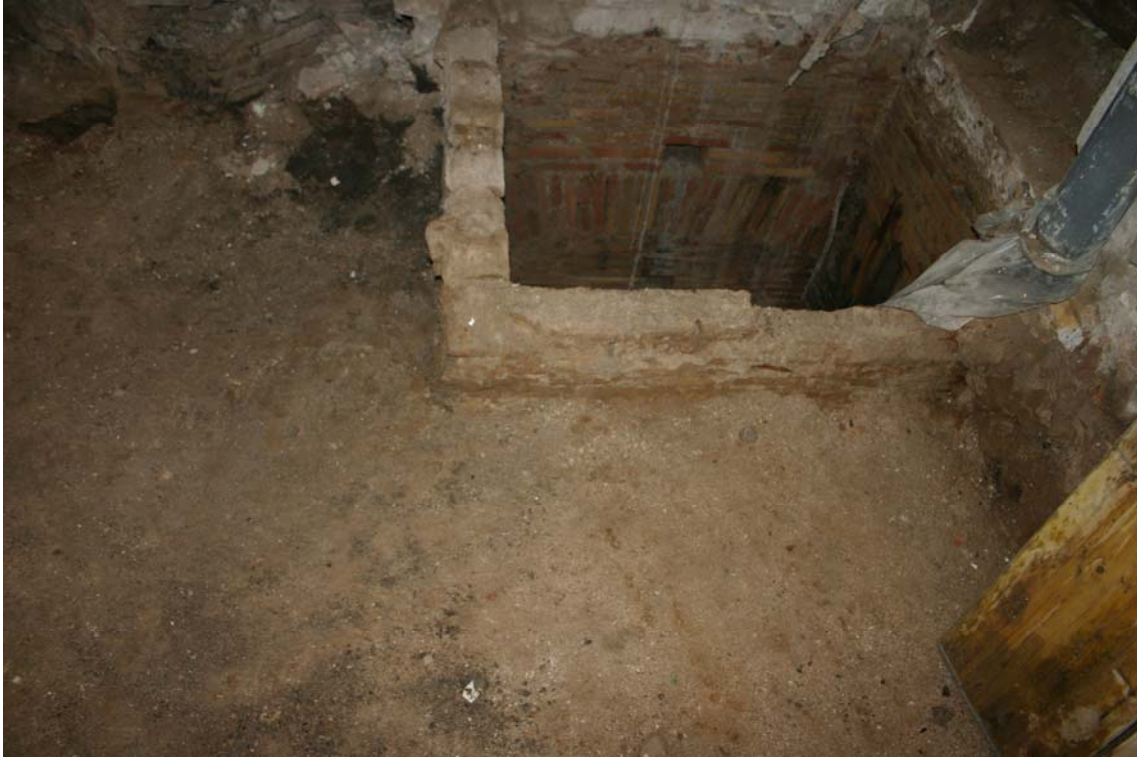
Vista del pou 1001, situat a la cantonada del pati de llums interior de la finca.
