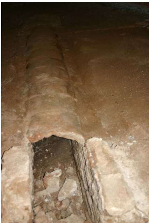
Detall de la coberta de peces semi-cilíndriques de la claveguera
