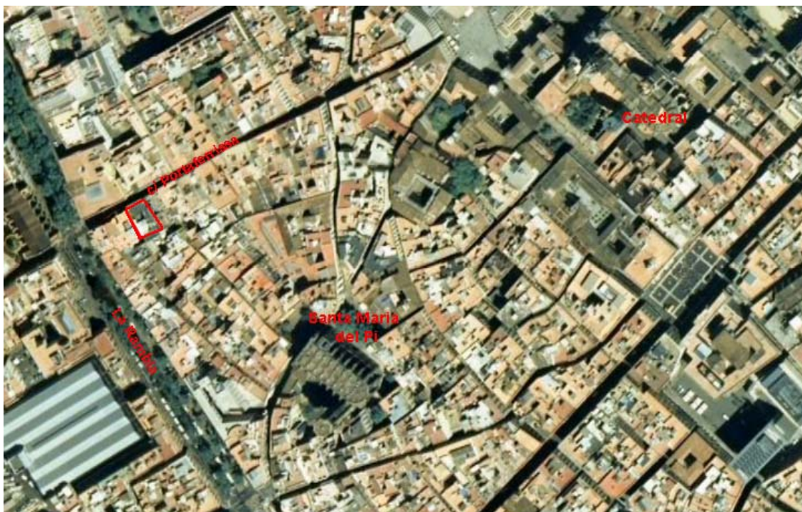
Vista aèria de la ubicació del solar dins el Barri Gòtic
