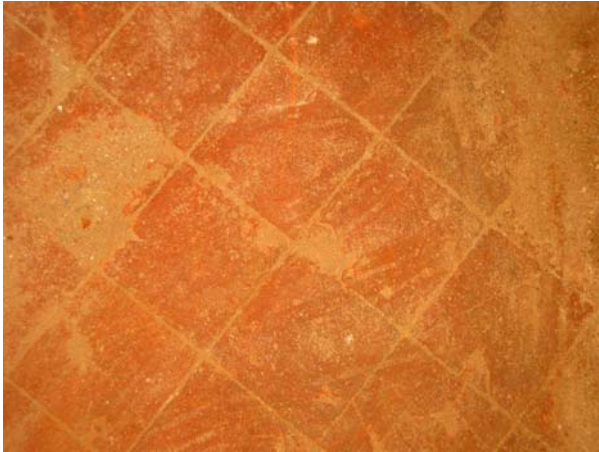
Vista del paviment de cairons U.E.5004.
