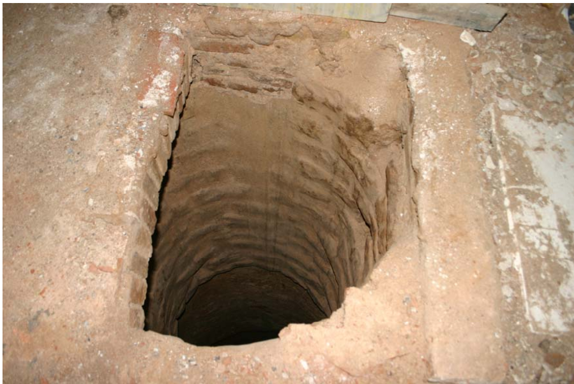
Vista de la part superior del pou 2003, amb les filades de maons disposades per suportar el paviment que amortitzava el mateix.
