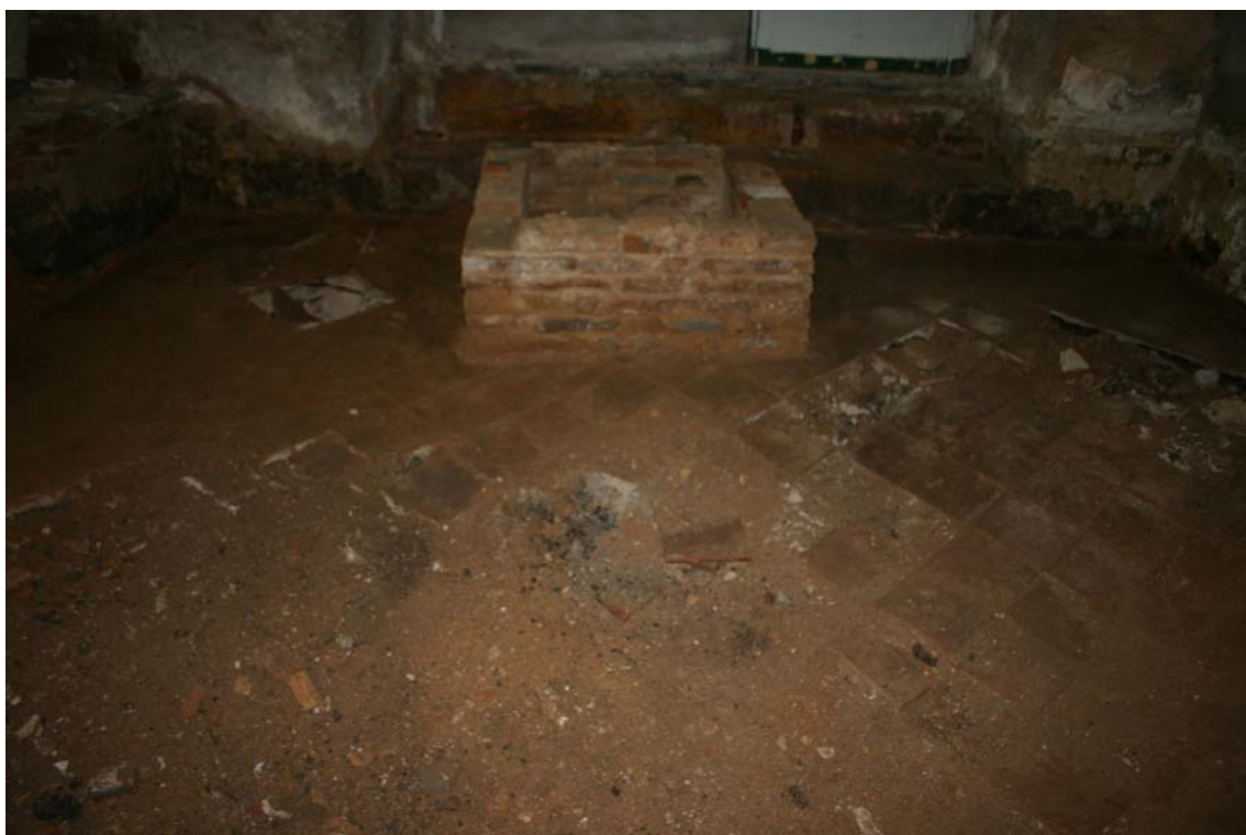
Vista de l'arqueta 3003 i de les restes de paviment 3004, molt afectades per l'anivellació posterior amb runa.
