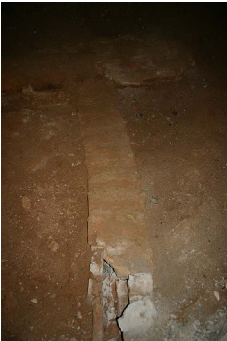
Vista de la claveguera 2006, amb coberta de maons plans.
