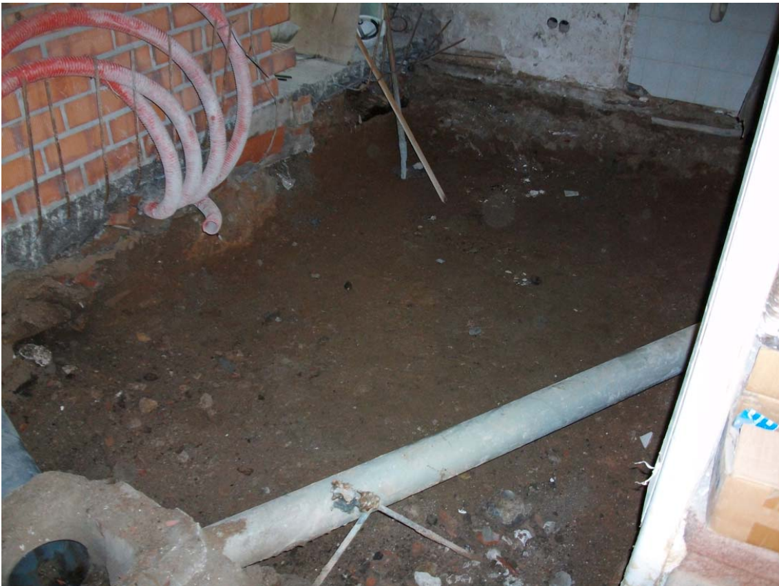
Vista general de la zona excavada.
