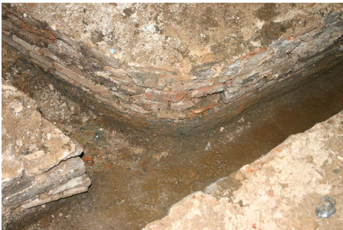
Detall del parament intern de la claveguera 2004, al seu punt d'unió amb el brançal 2005.
